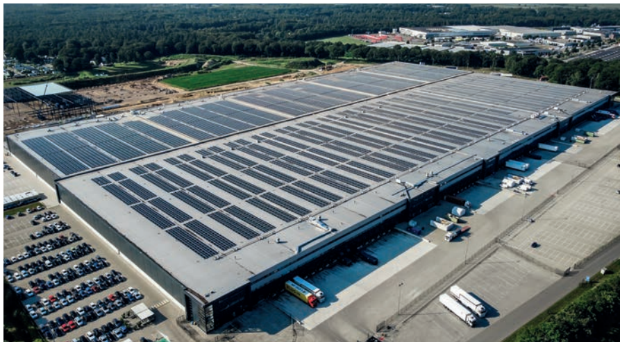
Photovoltaik-Anlage in Gennep, Niederlande
